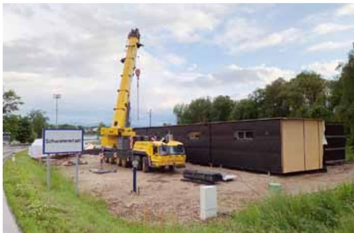
Ende Mai wurden im Bereich der Sportmittelschule die Fertigteil-Boxen der neuen Polizeiinspektion Schwanenstadt aufgestellt. Im Anschluss daran werden auf die von der Firma Obermayr im Werk vorgefertigten sogenannten „Go-Boxen“ das Dach und die Außenfassade montiert. Einer Übersiedlung der Polizeiinspektion vom Stadtplatz in das neue Gebäude gegen Ende Juli steht nichts mehr im Wege.
